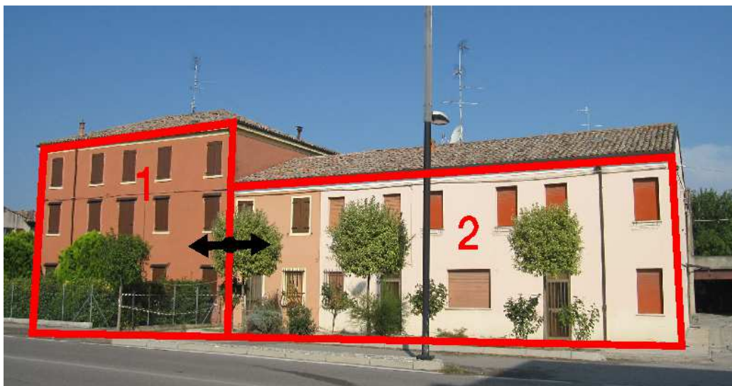
Esempio di interazione reciproca di UMI in aggregato con esito di inagibilità di tipo “E”.
