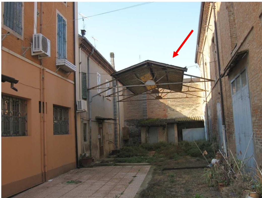
Esempio di elementi di confine di limitata interferenza strutturale (tettoia)
